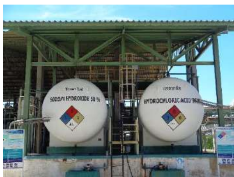
ภาพที่ 2.2-16 Dike สำหรับถังเก็บสารเคมีและถังสำรองเชื้อเพลิง
