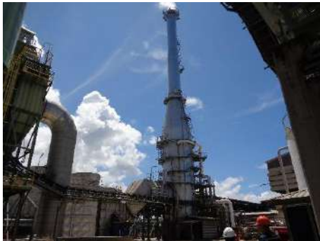
ภาพที่ 2.2-21 ระบบ Sea Water Scrubber
