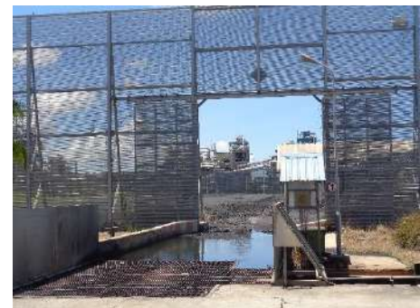
ภาพที่ 2.2-12 พื้นที่ล้างล้อรถบรรทุกก่อนออกจากพื้นที่ ลานกองเก็บถ่านหินกลางแจ้ง
