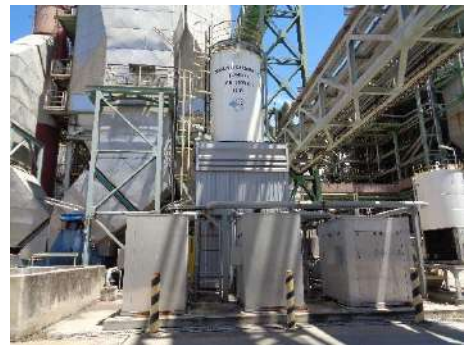
ภาพที่ 2.2-2 Wet Scrubber และ dry Scrubber
