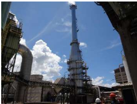
ภาพที่ 2.2-2 Wet Scrubber และ dry Scrubber
