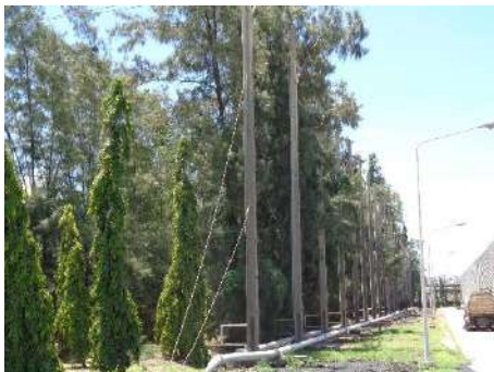
ภาพที่ 2.2-9 ม่านน้ำทางทิศเหนือของลานกองถ่านหิน ด้านที่ติดกับโรงงานอื่น
